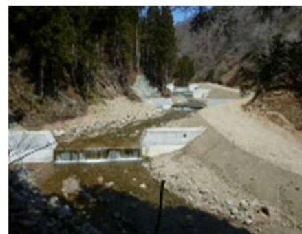
下流域への土砂流出を防止する治山ダム群の整備
