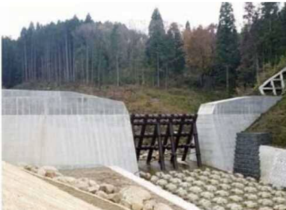
砂防関係施設整備
