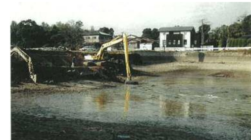
<ため池の浚渫工事>
